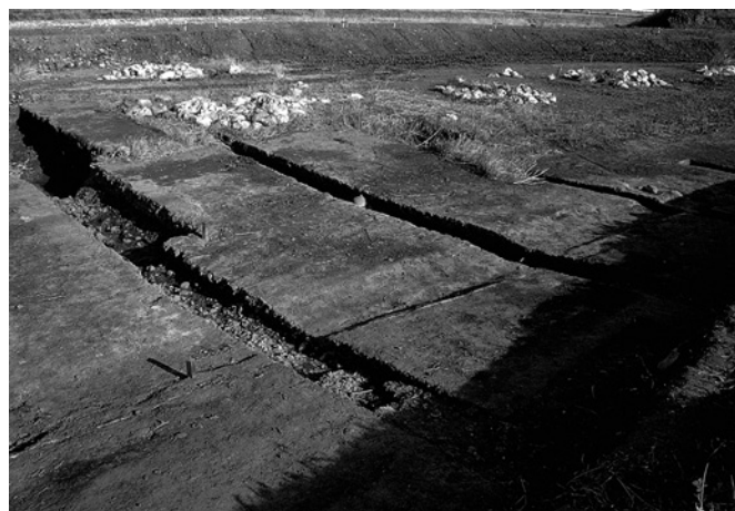
(7)-2 トレンチ設定状況
