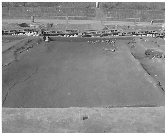
C-SD01直上 道路検出状況(東から)
