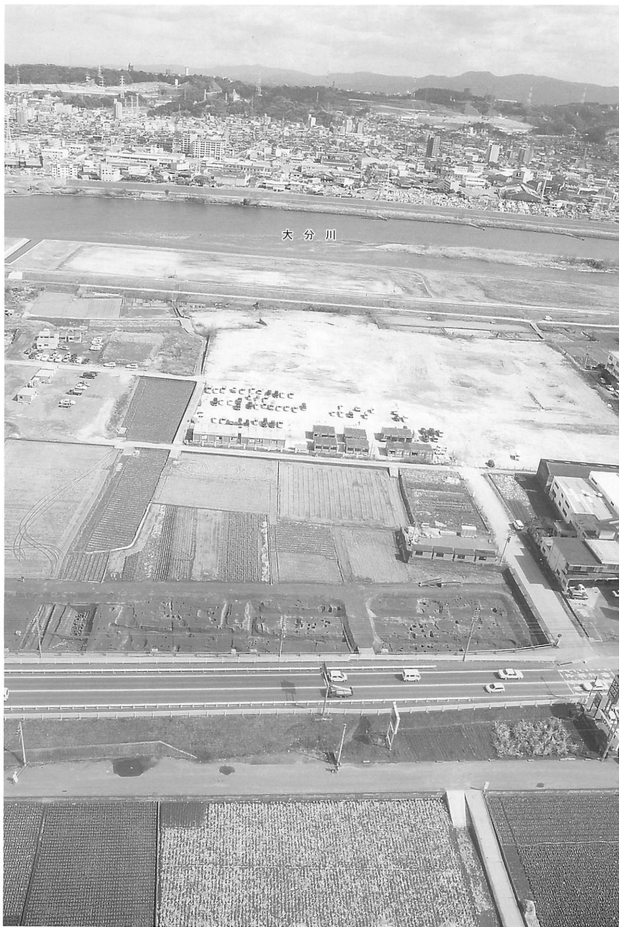
府内町跡20次調査区と万寿寺跡（西上空から）
