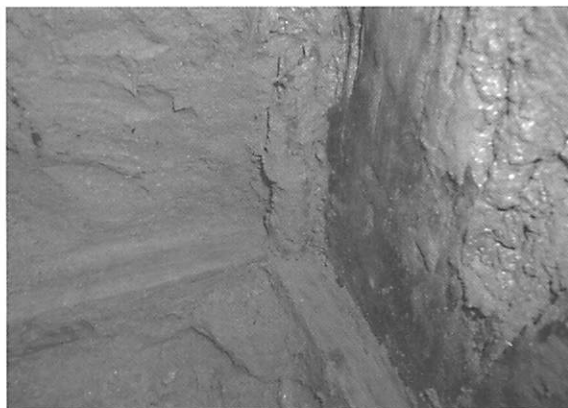
SE126 井側南隅横棧支柱
