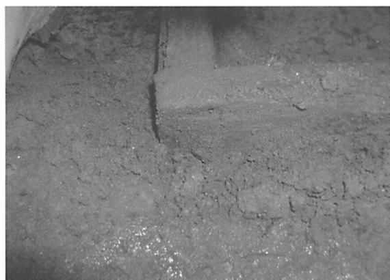
SE126 井側南側横棧接合部
