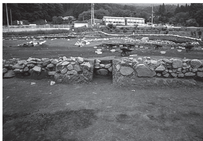
5 20区11号石垣 近接（東から）
