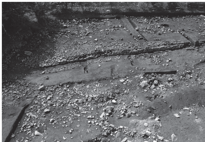
1 20区6号石垣 全景（北から）
