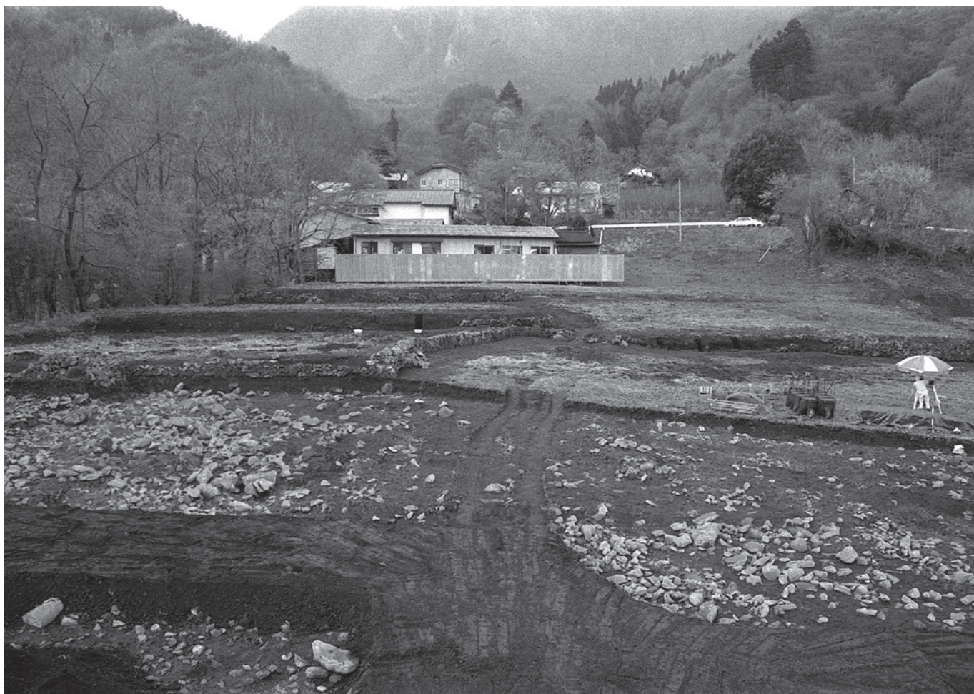
5 18区1号石垣 全景 (北から)
