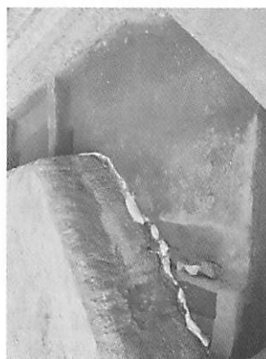
SF011 砂利面検出状況
