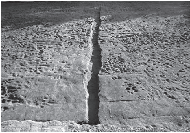
3. IV区6号溝全景 北から
