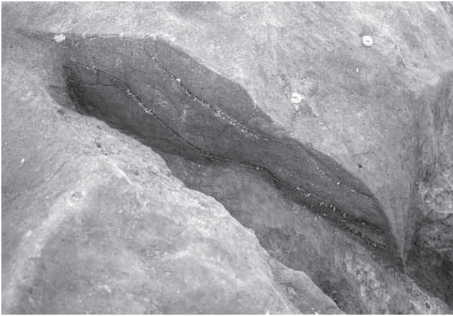
3. Ⅲ区1号橋脚断面 南から
