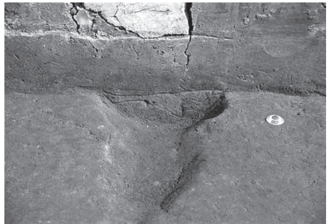
6. Ⅲ区66号溝断面 南から
