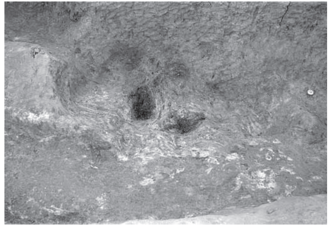
6. Ⅲ区2号橋脚板出土状況 西から
