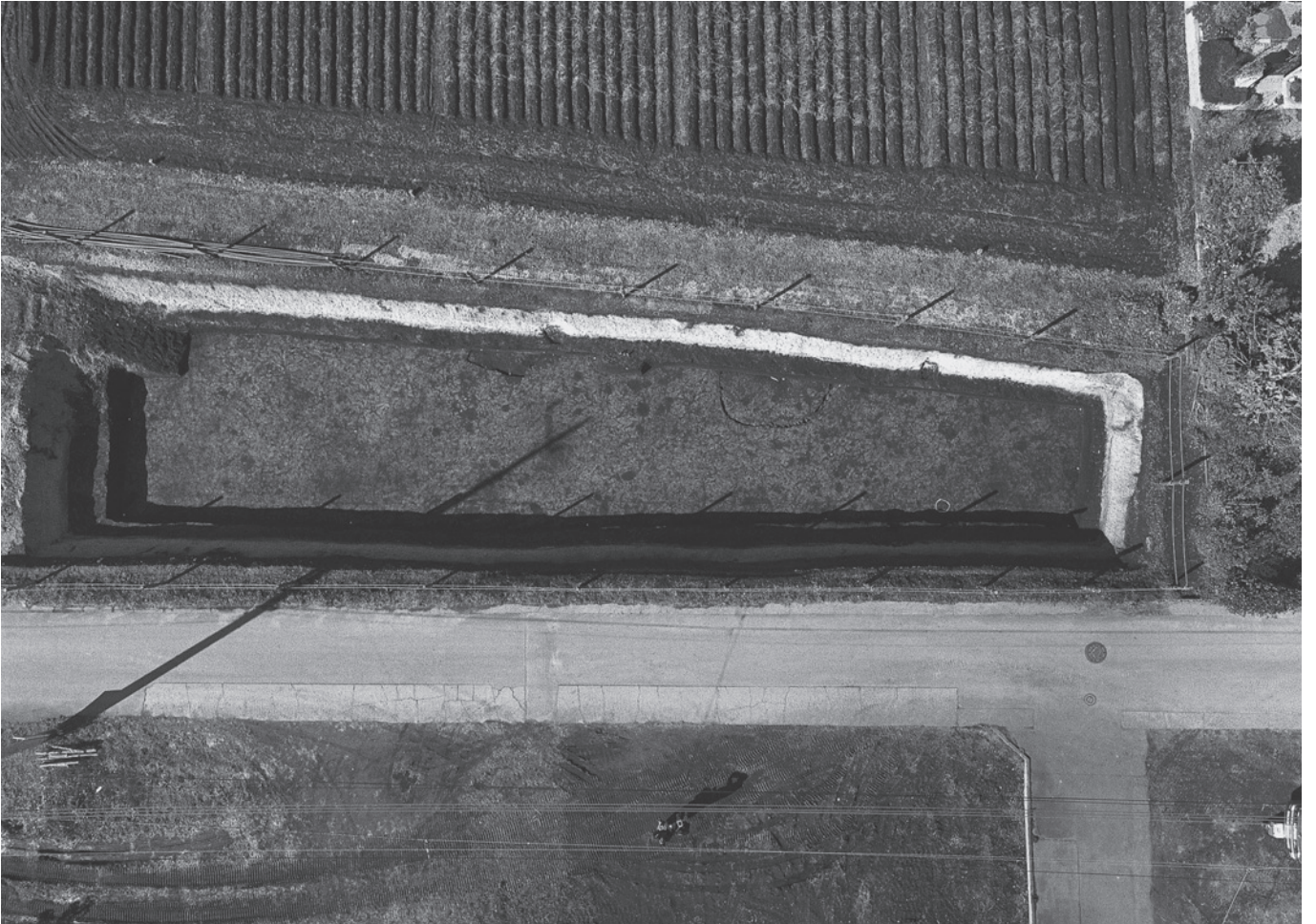
4区 調査区全景
