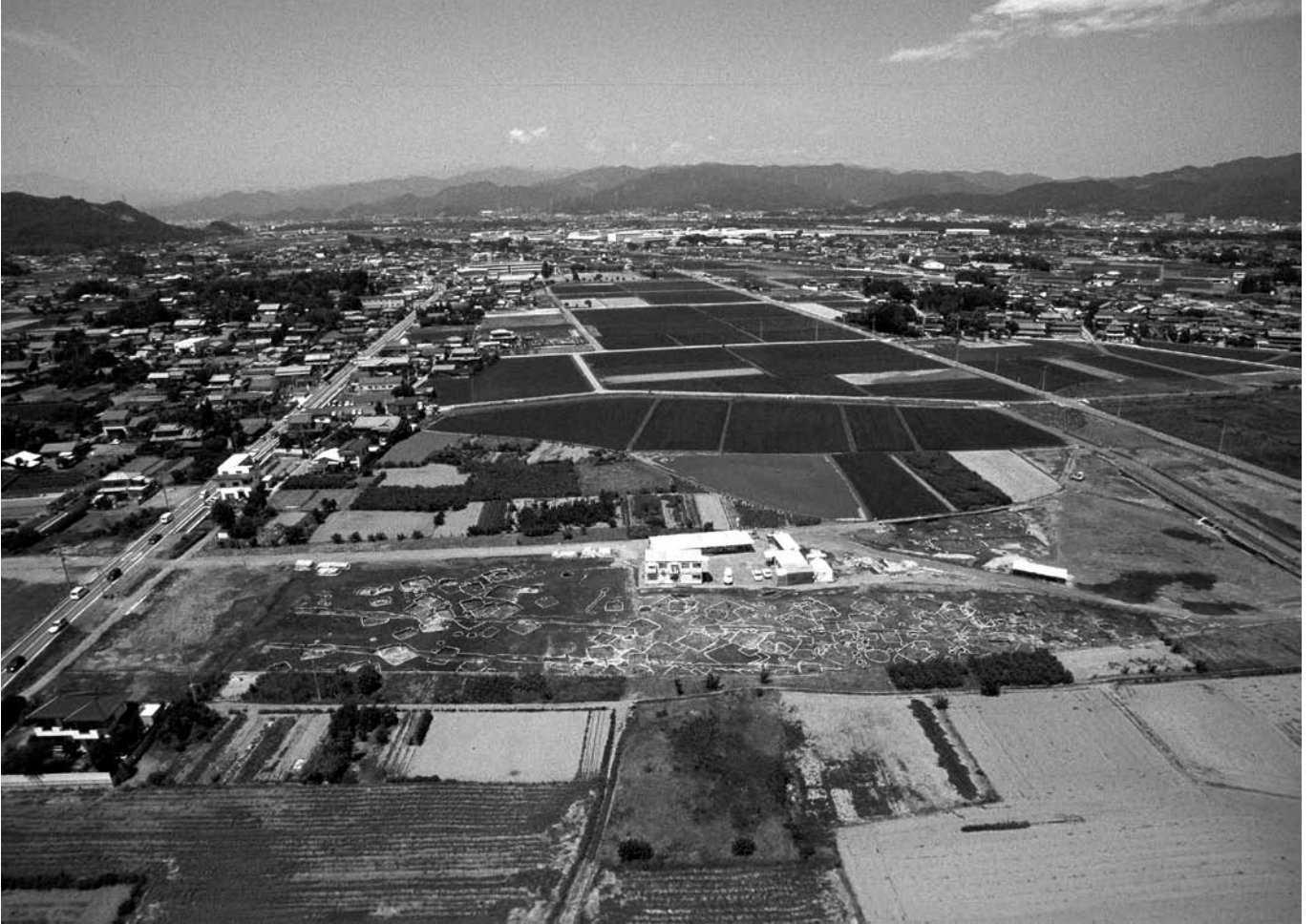
2区 3・4区南部全景(南から)
