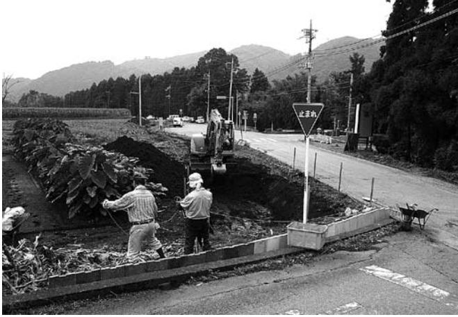
1. 表土掘削作業状況 (北から)
