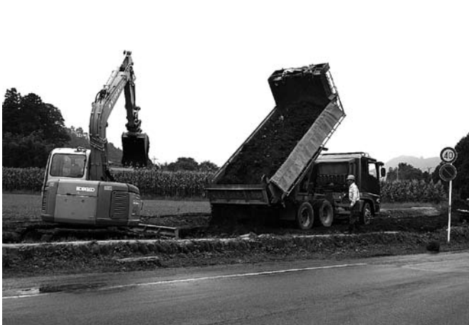
5. 埋め戻し作業状況(北西から)
