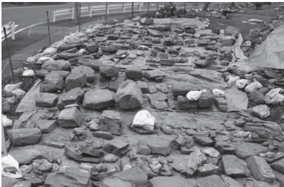
写真3 移築保存のための石室石材仮置状況
