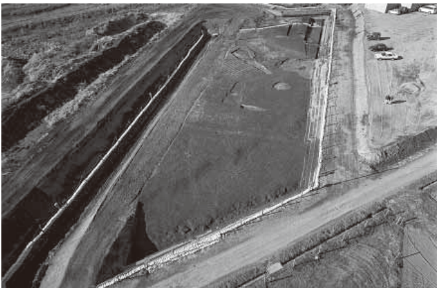
5. 4区 As-B 下面東半部全景 (南から)
