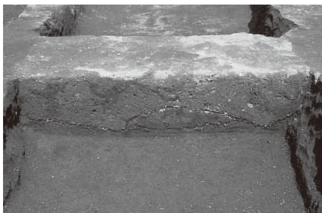
3. 2区復旧溝土層断面 A-A' 溝3(南から)
