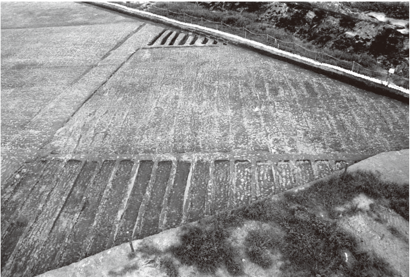
5. 4区第2洪水層復旧溝6・7・8区画全景(北東から)
