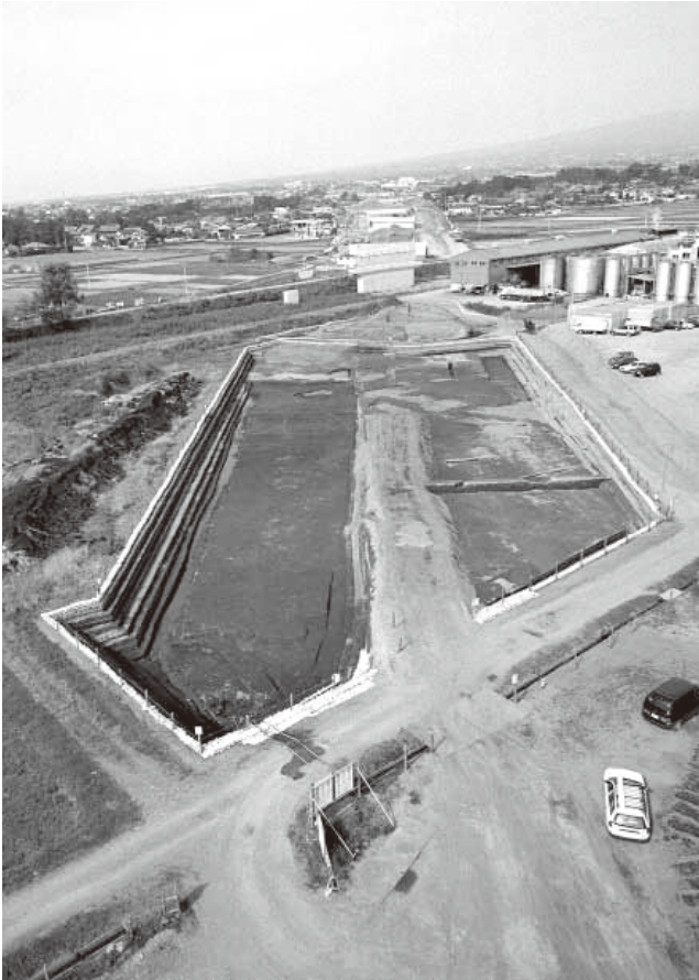
1. 4区の調査区全景(南から)
