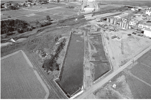
1. 4区 As-B 下面西半部全景 (南東から)
