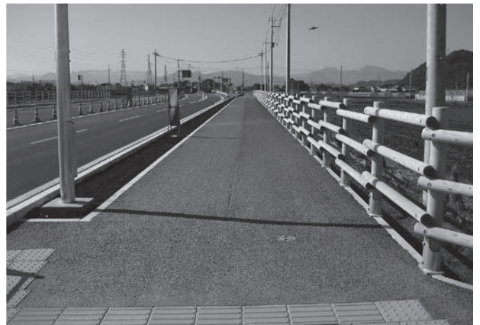
工事完了後風景(東から)
