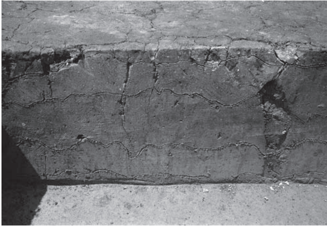
2号試掘坑西壁土層断面(東から)
