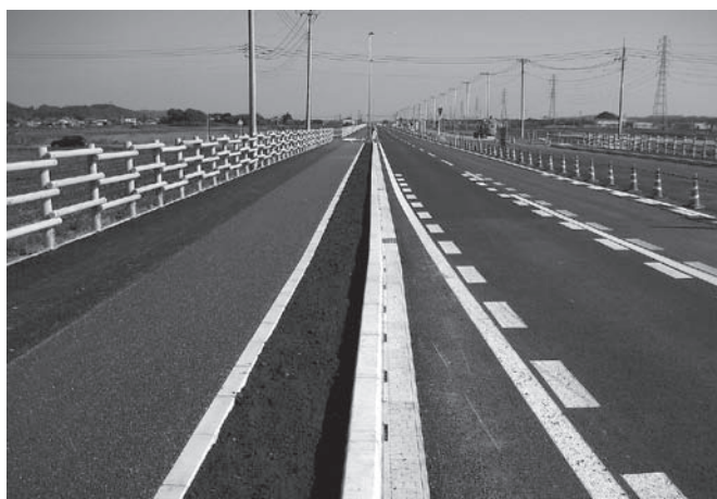
工事完了後風景 (西から)
