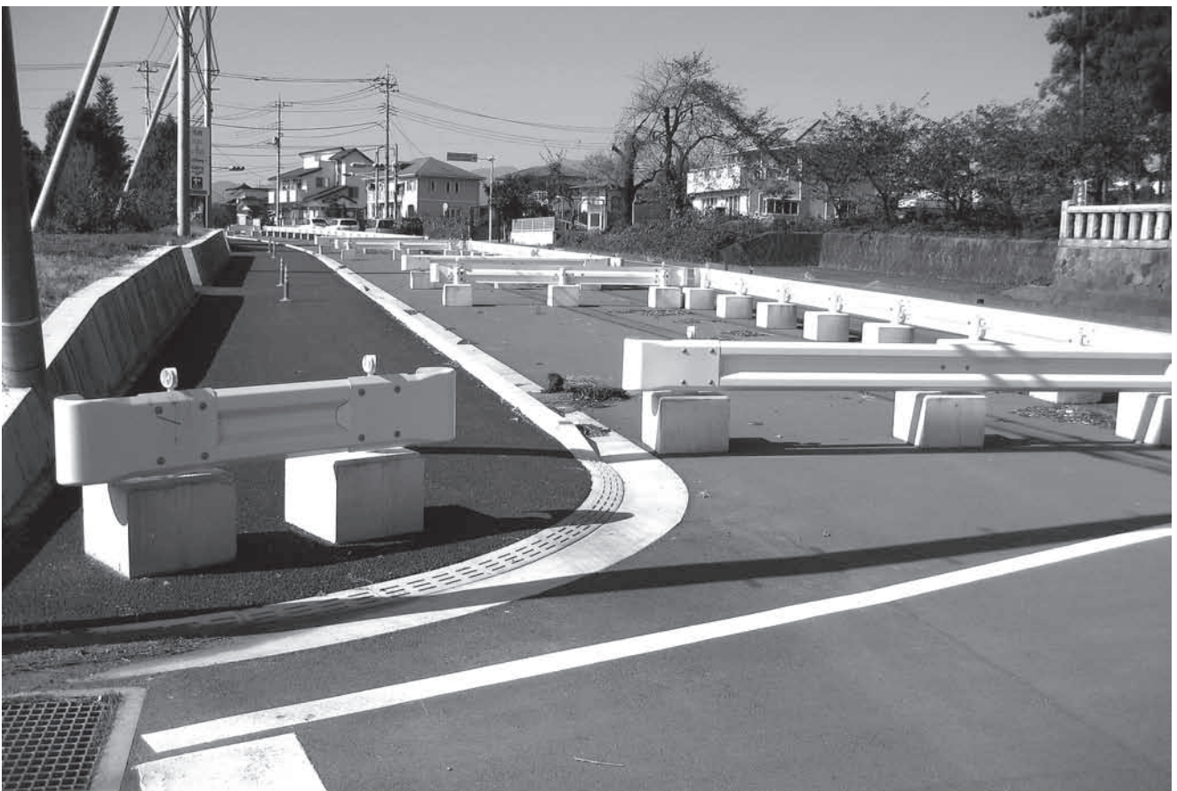
工事完成後(東から)
