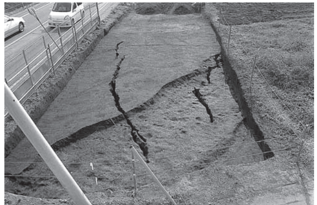
1号道全景及び地割れ痕（北より）
