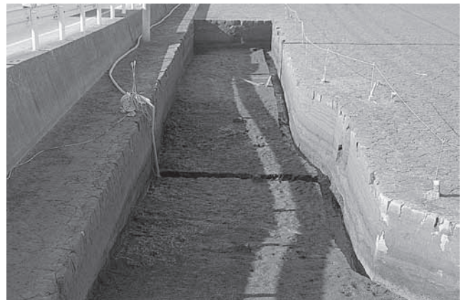
As-C 混土下面 (6区張出し、東より)
