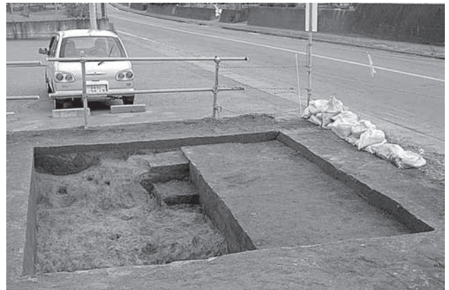
2区調査状態（西より）
