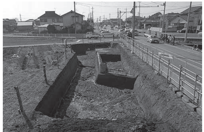
As-B 下水田全景（北より）
