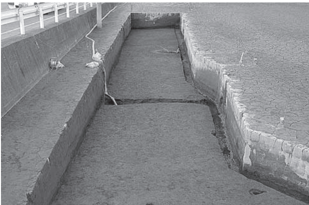
As-C 混土下水田面 (6区張出し、東より)
