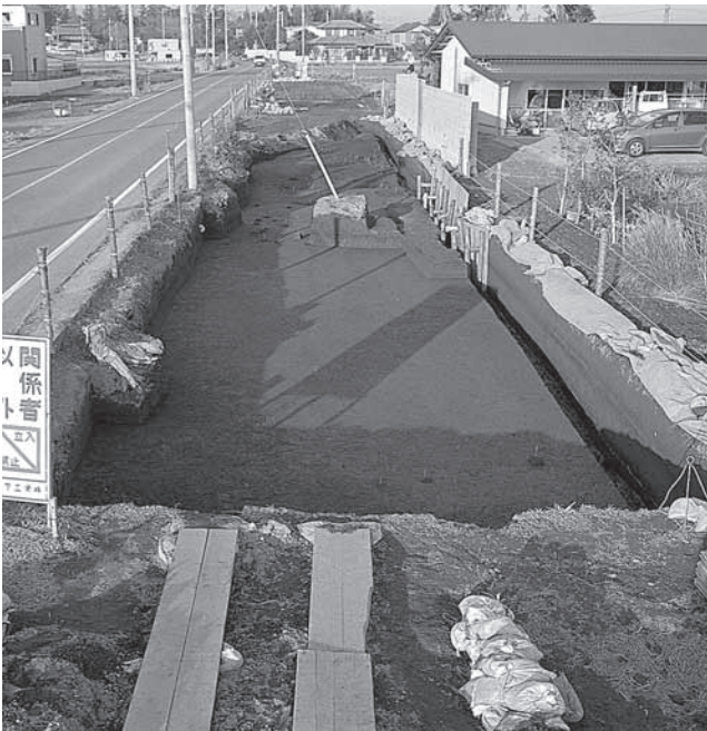
2面全景（1区、南より）
