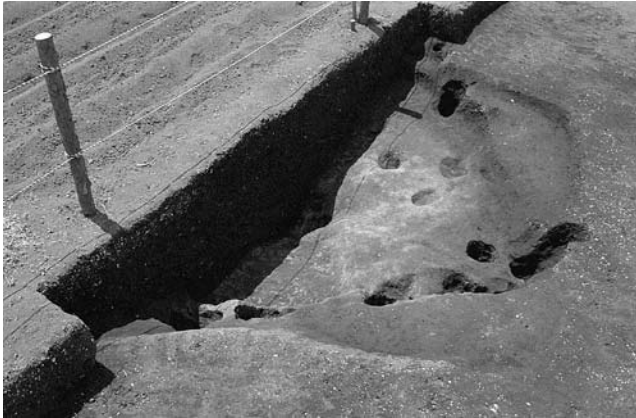
D区2号工房掘方 北から
