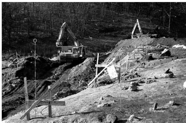
85区埋め戻し作業風景（東から）
