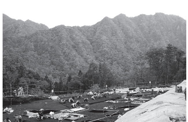
作業風景（北から）
