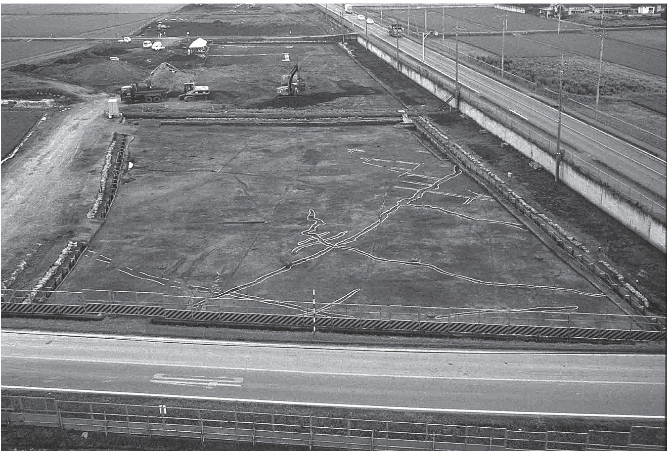
2. Ⅷ区第3面全景東から
