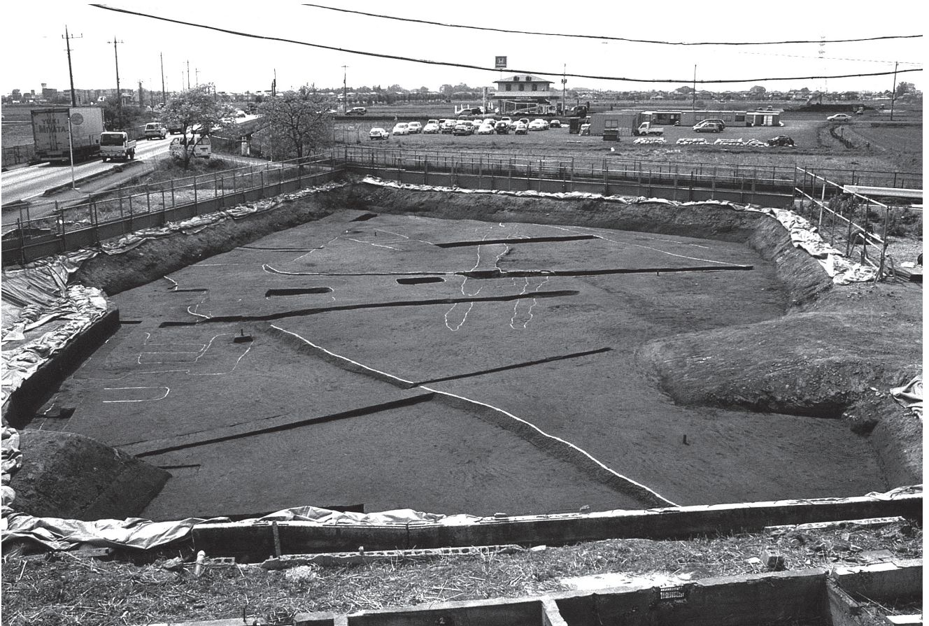
1. Ⅲ区第1面全景東から
