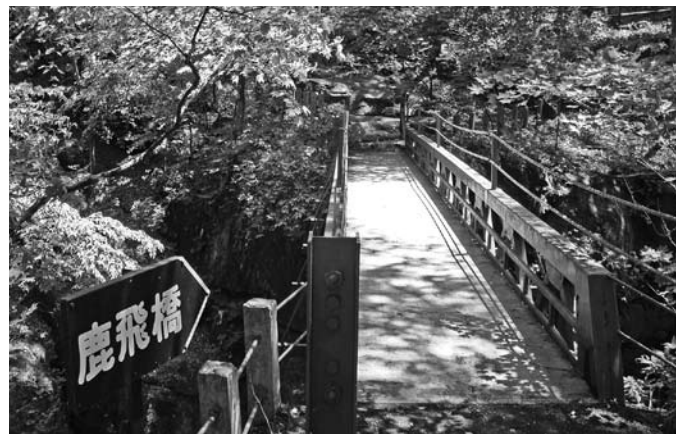
8 吾妻峡鹿飛橋 北→
