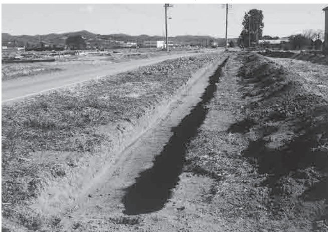
III区17号トレンチ (西から)
