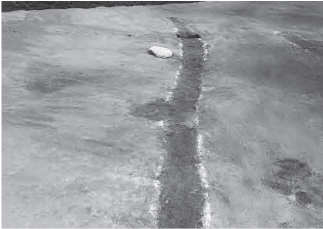
1面8号溝 (南西から)
