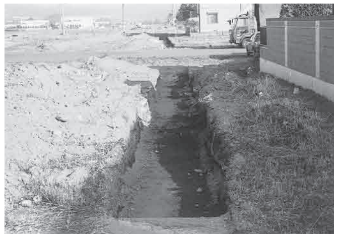
III区18号トレンチ (西から)
