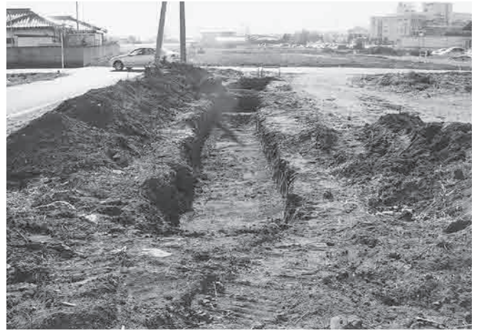
II区6号トレンチ (北から)
