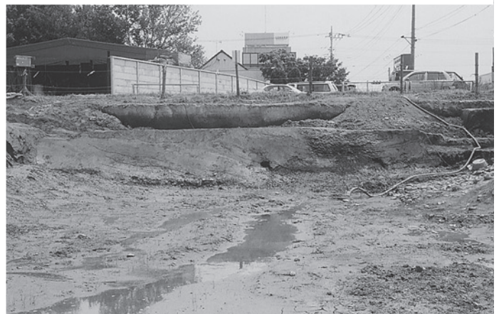
5 3区第5面用水路土層断面(西から)
