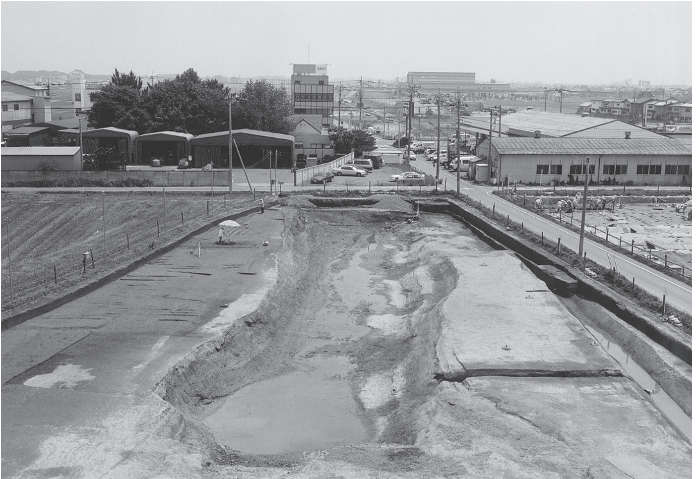
1 3区第5面用水路(西から)
