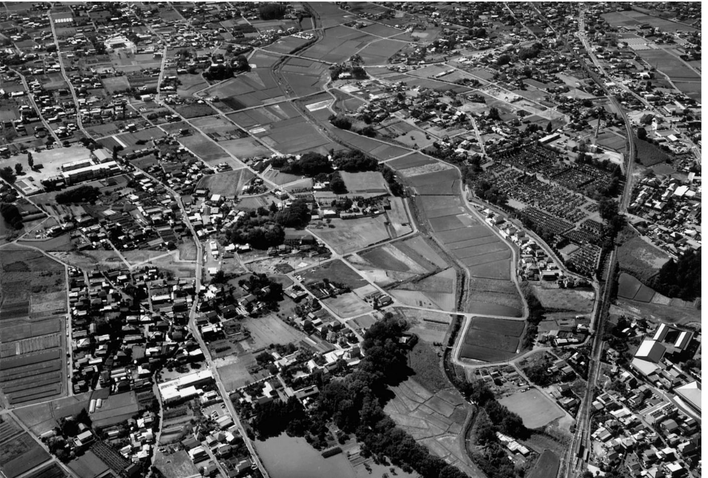
2 上武道路予定地を北東上空から望む
