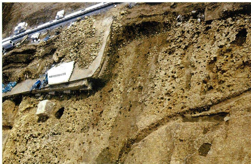
平成 19 年度 検出された遺構⑧ 削られた岩盤・溝状遺構。
