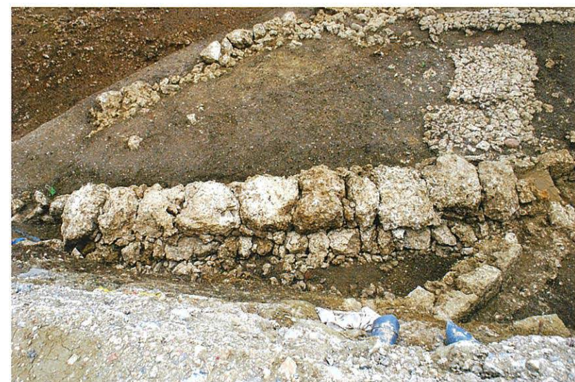
2区 排水溝7 暗渠蓋石検出状況
