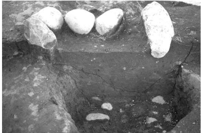
33号住居炉 土層断面 (←南)
