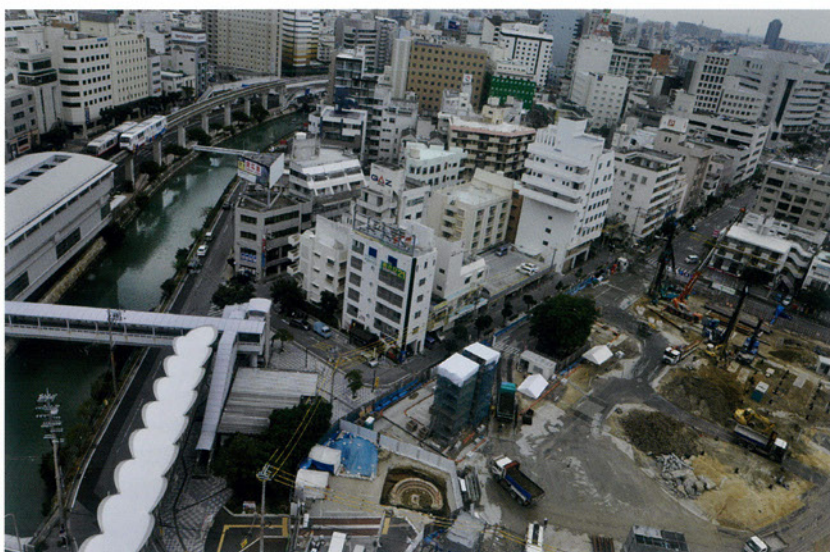
調査地遠景 南西より 左手にモノレール旭橋駅がみえる。
