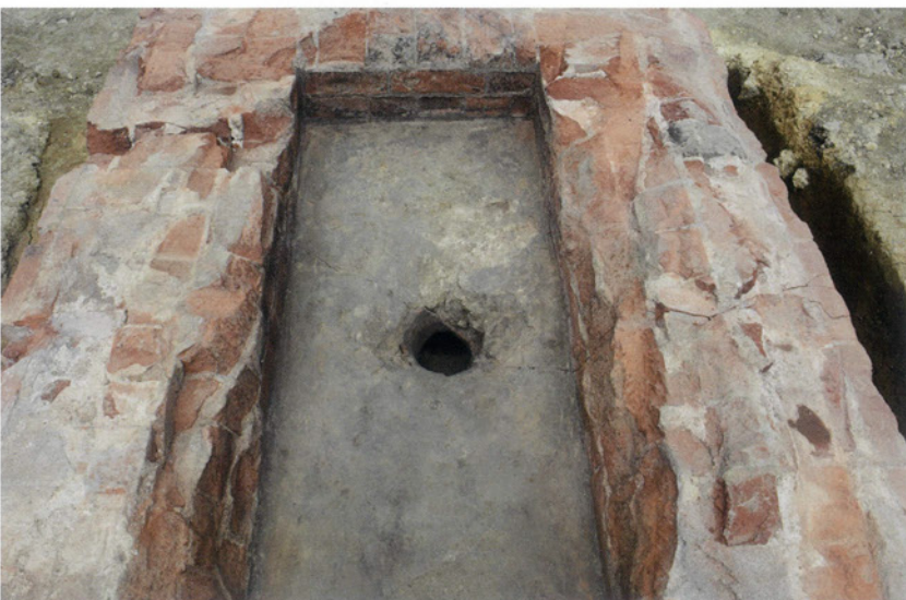
2号遺構集水口 南東より 集水口へ水が集まり易いようにモルタルで勾配をつけている。
