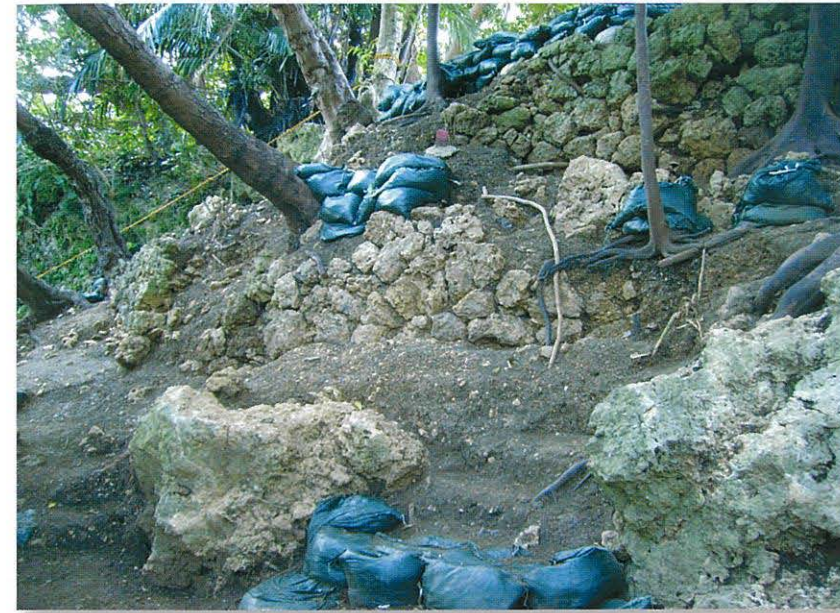
築山後方斜面の土留め石積み
