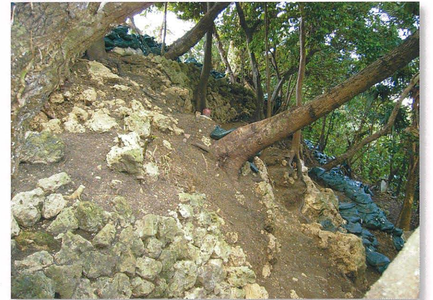
築山後方斜面の土留め石積み
