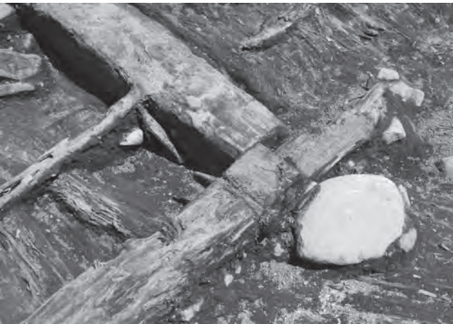
⑤ 材5 ホゾ穴破断状況
