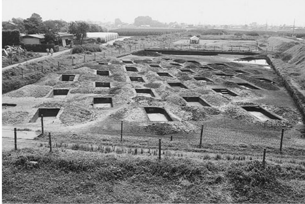
1. 本線部Ⅲ区（西半）試掘状況
