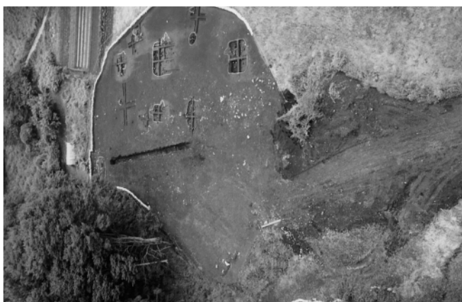
95区航空写真（上空から）
