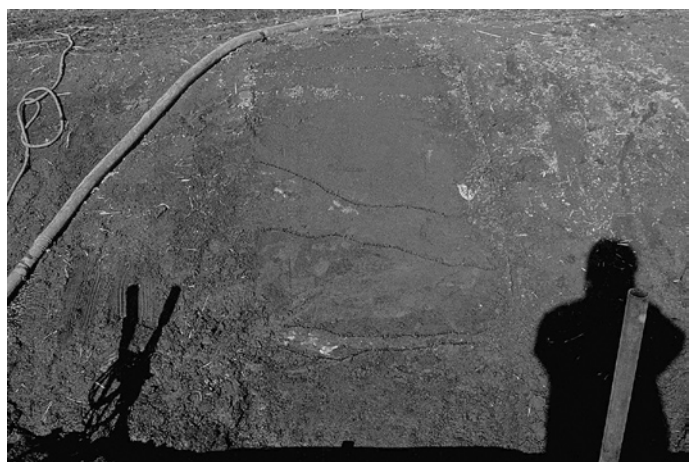
I区Aセクション 南から
