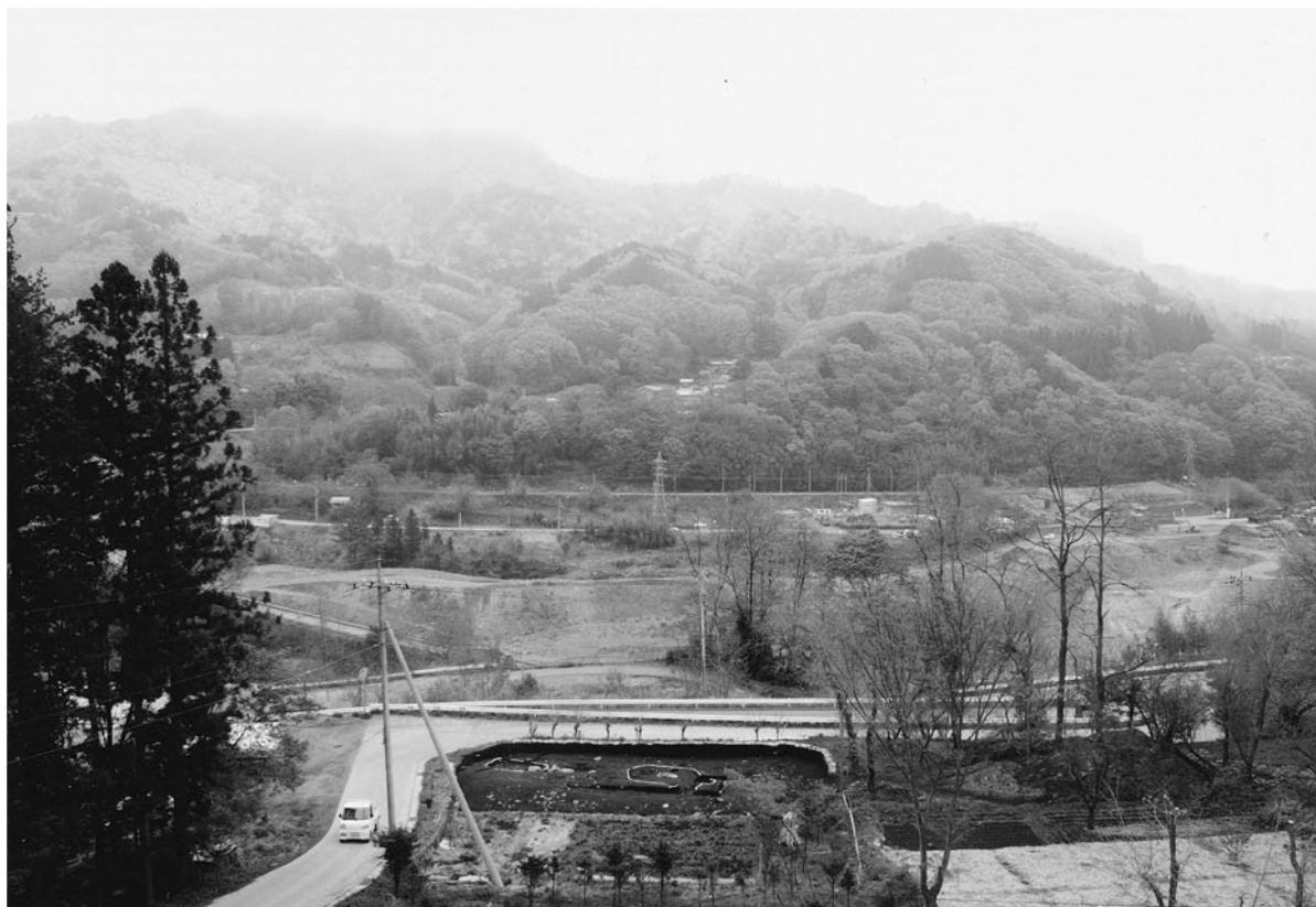
1. 23・24区遠景（南西から）
