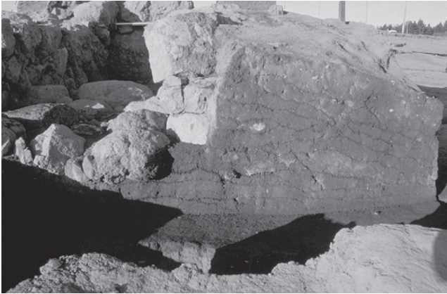
1 2号墳 墳丘盛土 断面 f-f' (南→)
