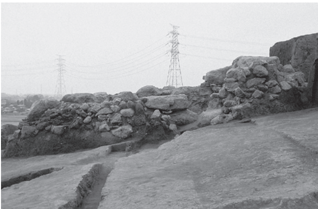
5 2号墳 石室東側壁 石積み背面状況 (東→)
