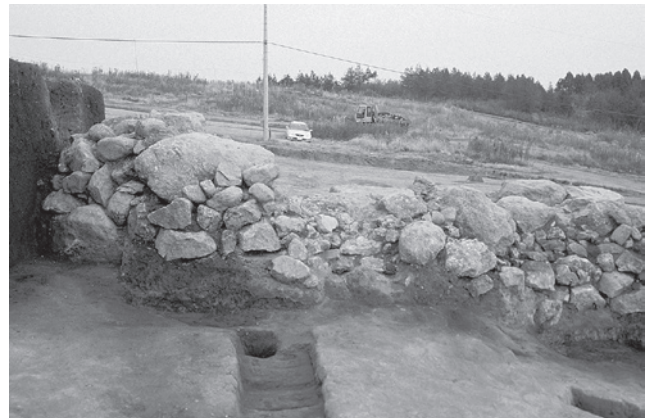
4 2号墳 石室西側壁 石積み背面状況 (西→)
