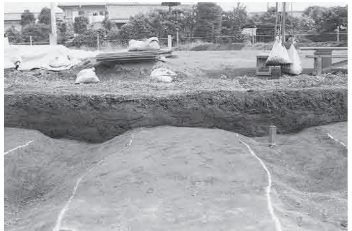
6. 6号・7号溝セクションE 南から
