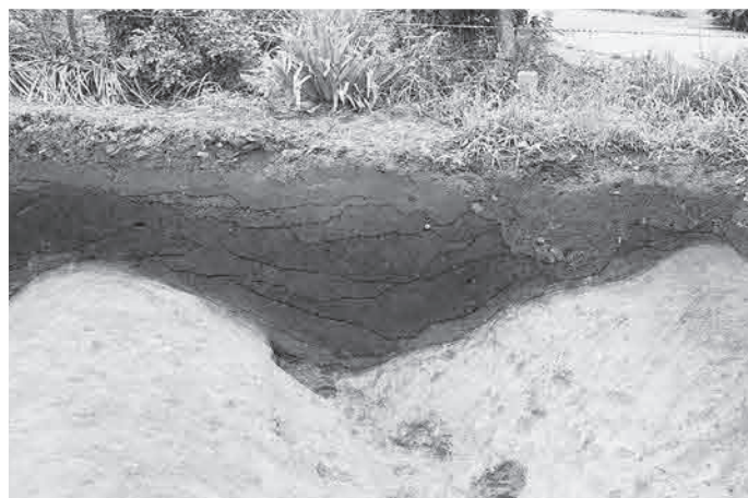
8. 5号溝セクションI 北から
