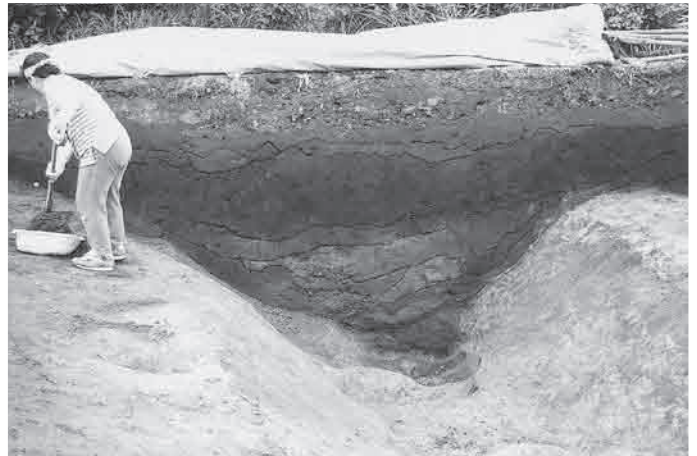
4. 4号溝作業風景 北から
