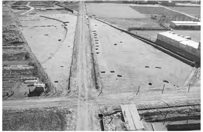
2 3b区・3c区全景(北から)
