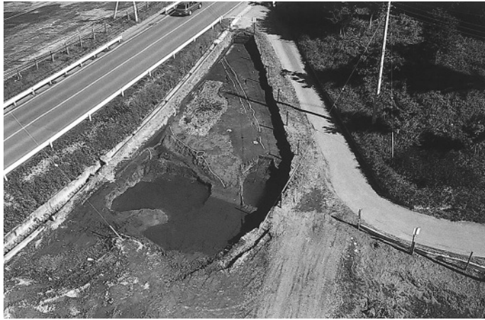
1 A区P9地点全景(南西から)
