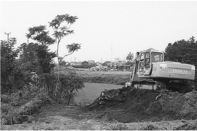
3 A区P 6地点遺構検出状況(東から)
