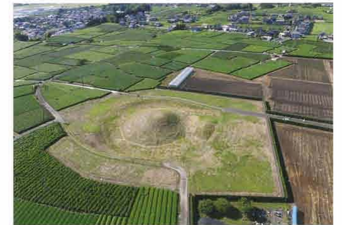
吉岡大塚古墳 工事着手前 北から
