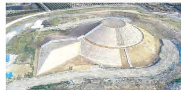
30年度工事完成 南から
