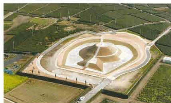
令和元年度 工事完成 西から
