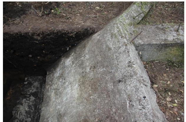
⑥ 3号掩体壕第3トレンチ状況 外側の掘り下げと外傾するコンクリート基礎の状況
