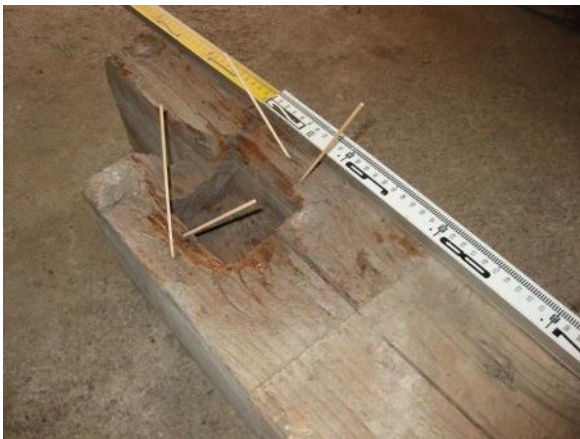
写真 25： 長方形ほぞ穴を有する A 材仕口部
