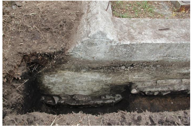
② 3号掩体壕第3トレンチ状況 袖部外側の掘方及び捨てコン状況
