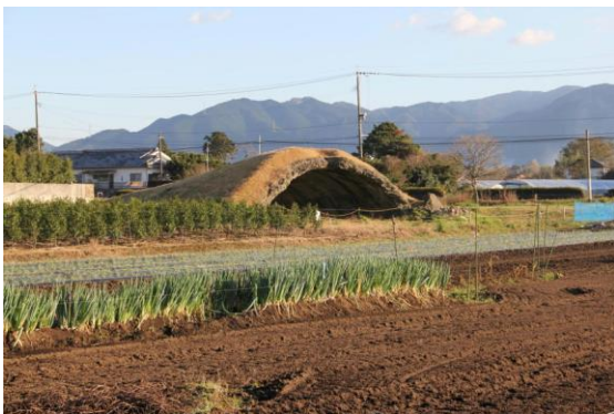
写真 76: 出水海軍航空隊 2号掩体の外観
