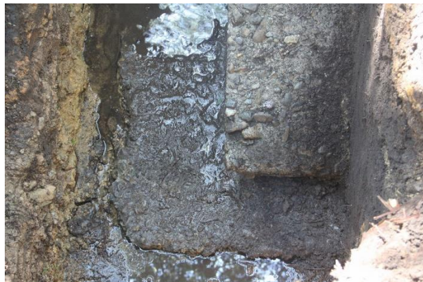
② 5号掩体壕第4トレンチ状況 斜方向に打設した捨てコン状況
