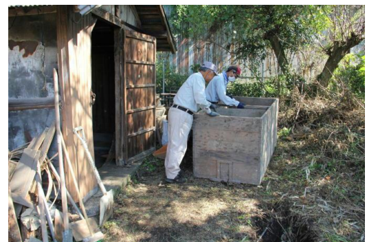
写真 48: 粗入れ大型ひつの解体作業
