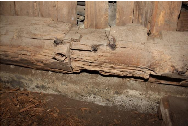
③ 3号掩体壕柱材 小屋内の「ア・イ両材」の仕口での結合状況
