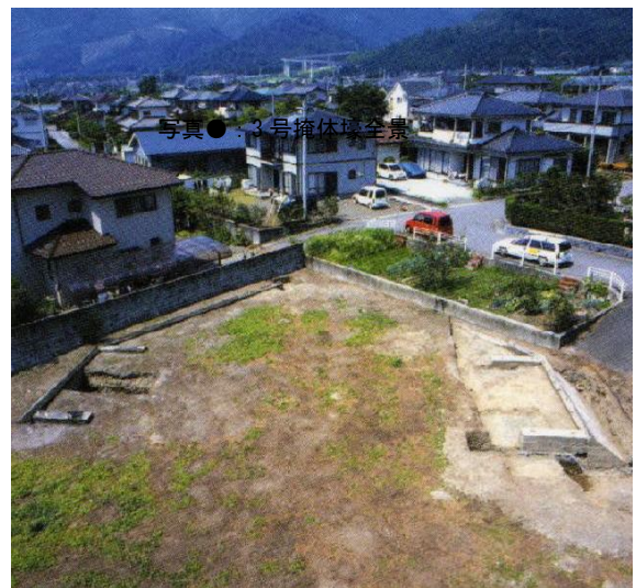
写真14: 3号掩体壕全景
