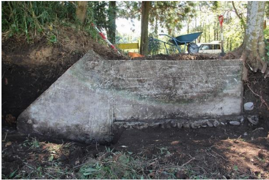
① 2号掩体壕第1トレンチ 左側手前袖部のコンクリート敷設状況と堀方ライン
