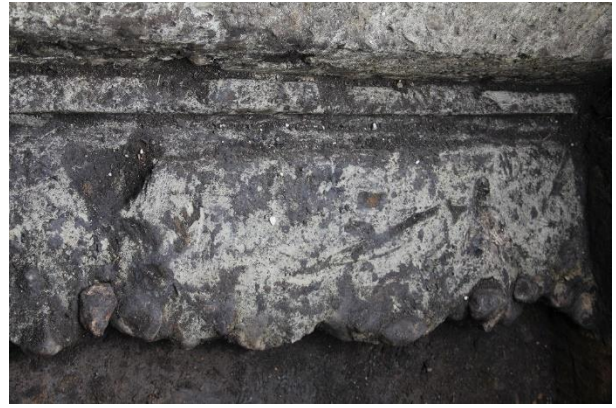
② 3号掩体壕第3トレンチ状況 外側最下層の捨てコンの敷設状況、板目状況
