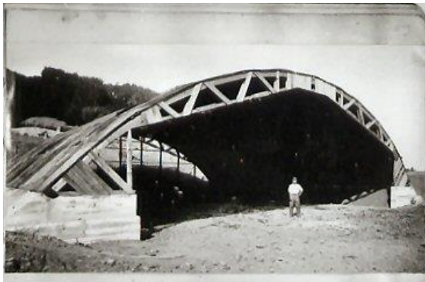
写真 68 : 左 木製格納庫事例 (20m×20m規格) 立川航空機製造所疎開工場での施工例 写真 69 : 右 膠着梁大張間掩体壕 (20m×30m規格) 山梨県飯野町龍王現場での施工例
