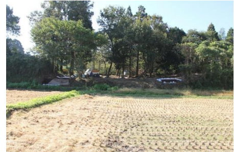
写真 78 県道 48 号（岡原通り）・北側から見た 2 号木製有蓋掩体壕 刈り入れ後の掩体壕開口部と全容
