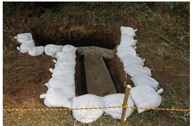
⑥ 2号掩体壕の環境整備 オープン部への安全ロープ設置と土嚢による 縁辺部補強状況
