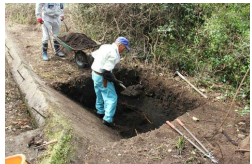
写真 46: 第2トレンチ外側(前室・奥室変換点箇所)の擁壁外側の掘り下げ状況
