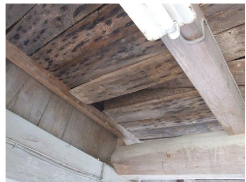
写真 21： 納屋の床板に利用された梁材
