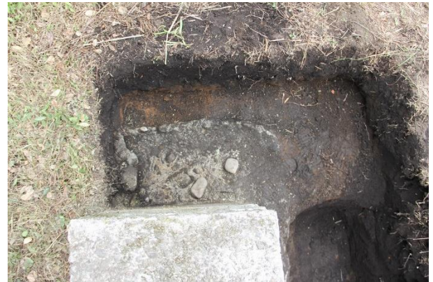
④ 3号掩体壕第3トレンチ状況 袖部の基礎設置状況と捨てコン状況
