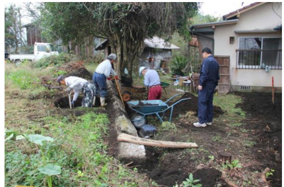
写真 47: 第5トレンチ擁壁部の確認作業の様子
