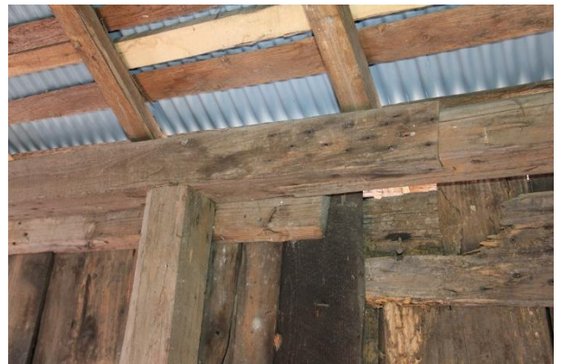
④ 3号掩体壕柱材 小屋内の方形柱材利用の様子
