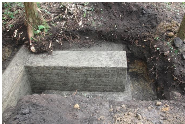
③ 4号掩体壕第4トレンチ状況 袖部コンクリート基礎の状況
