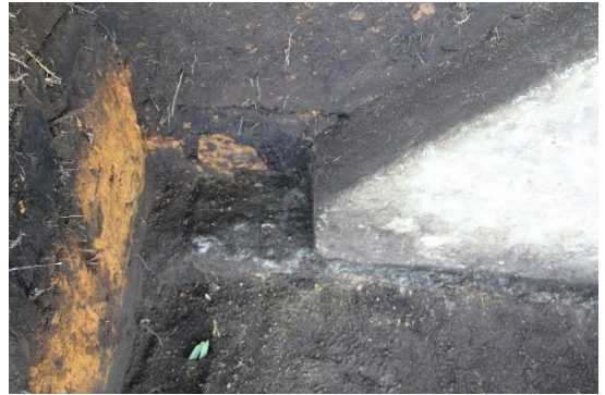
② 2号掩体壕第1トレンチ 直打ち状況、堀方ライン
