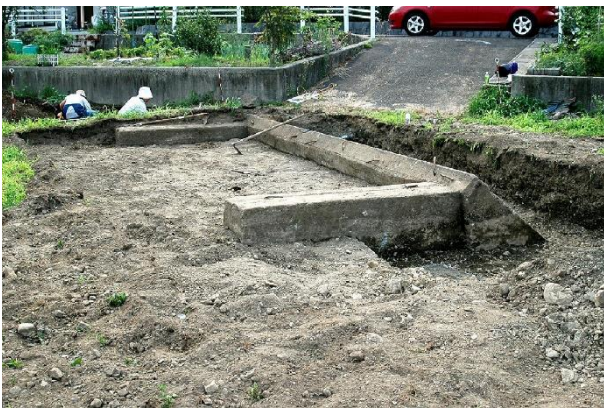
写真12: 3号掩体壕コンクリート
