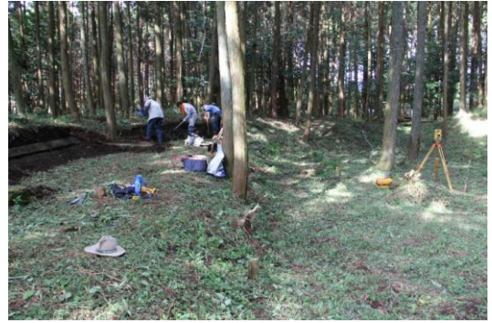
写真 51: 4号木製有蓋掩体壕の調査当初の様子
