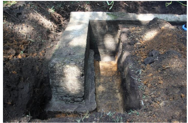
② 4号掩体壕第1トレンチ状況 袖部と擁壁基礎部の状況
