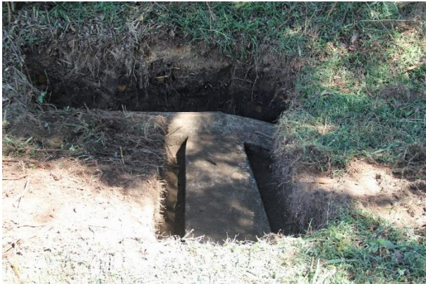
③ 2号掩体壕第2トレンチ コンクリート基礎部の検出状況
