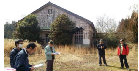
写真9： 通称「岡本工場」の現存建物
