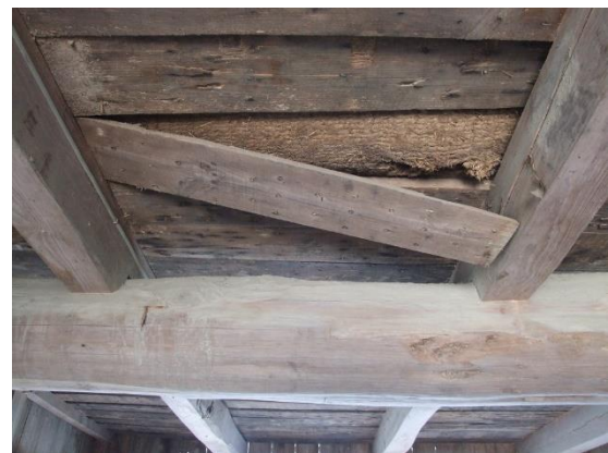
⑥ 1号掩体壕の調査
