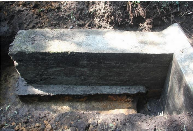
① 4号掩体壕第1トレンチ状況 袖部の掘り下げと捨てコン状況
