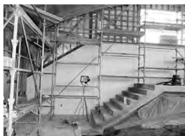
36-9 壁面断熱材工事
