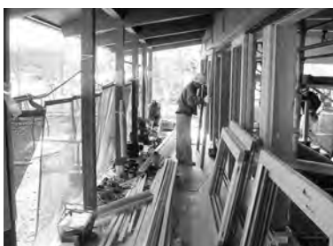
36-8 底部分の工事
