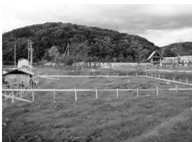
36-4 露出展示棟工事前
