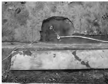
37-15 排水工事 (施工前)
