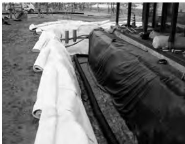
37-14 雨水対策工事
