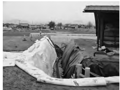
37-13 雨水対策工事①
