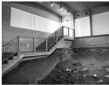
37-12 ブラインド設置工事
