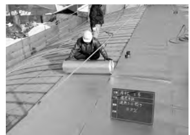
36-10 屋根断熱材工事
