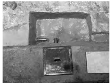
37-16 排水工事 (施工後)
