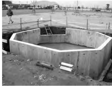
30-5 基礎工事②
