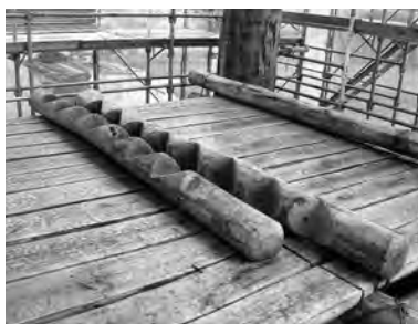
20-14 2階部分の床板
