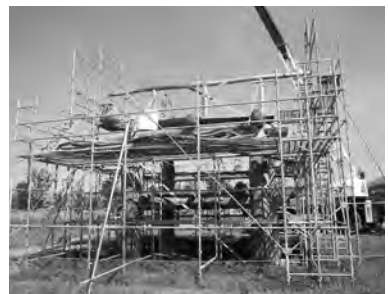
20-9 梁桁・棟持柱の組み上げ
