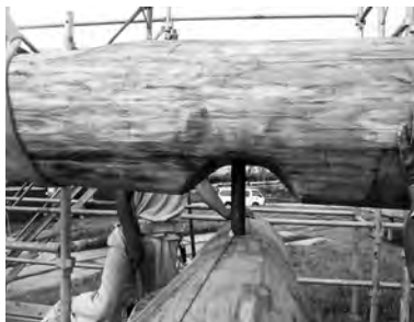
20-8 アンカーボルトによる固定
