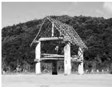
20-11 組み上げ状況
