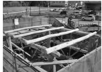
27-9 組み上げ工事
