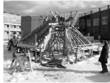
30-3 仮組み工事②
