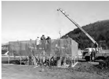
27-8 クレーン車による組上工事
