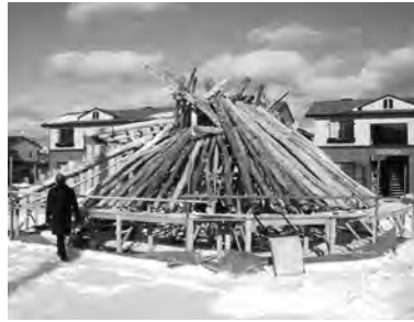
30-2 仮組み工事①
