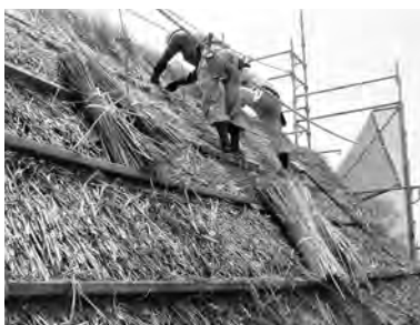
20-13 茅屋根工事②
