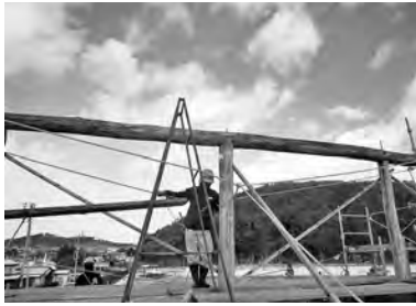
27-4 棟持ち柱工事①
