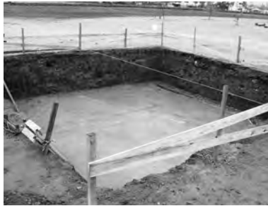
30-4 基礎工事①
