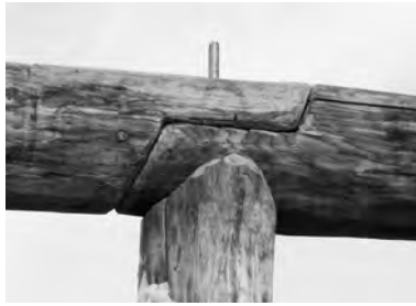
27-5 棟持ち柱工事②
