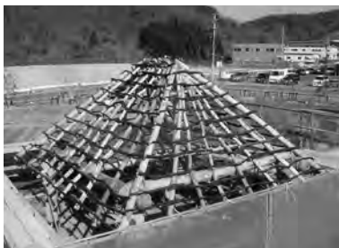
27-10 寄せ棟屋根工事
