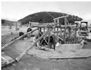
30-7 主柱、梁桁の組み上げ
