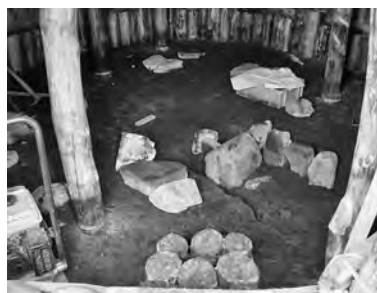
30-14 複式炉復元工事
