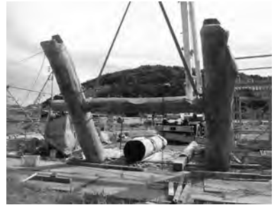
20-6 主柱の組み上げ①
