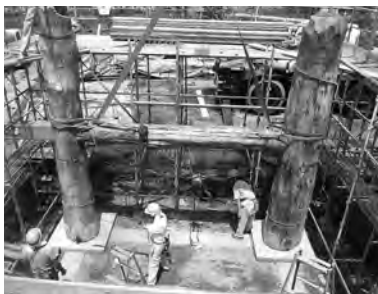
20-7 主柱の組み上げ②
