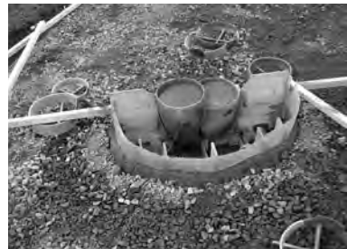
33-9 現地での仮設置工事
