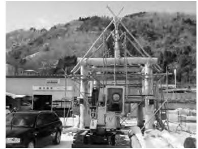
27-3 仮組み工事②
