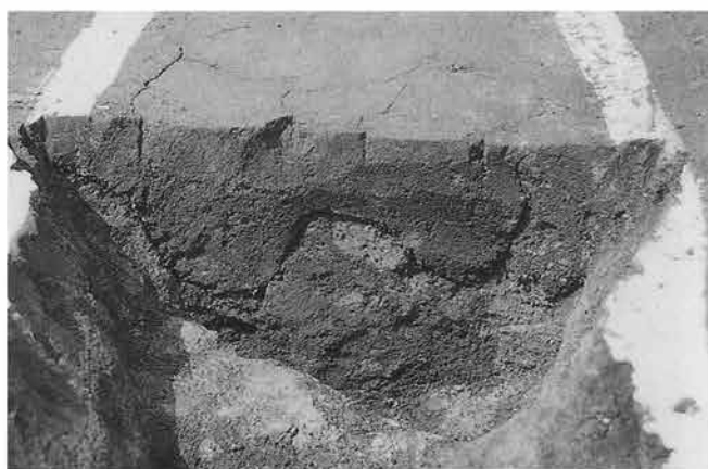
16号溝断面 (東から)
