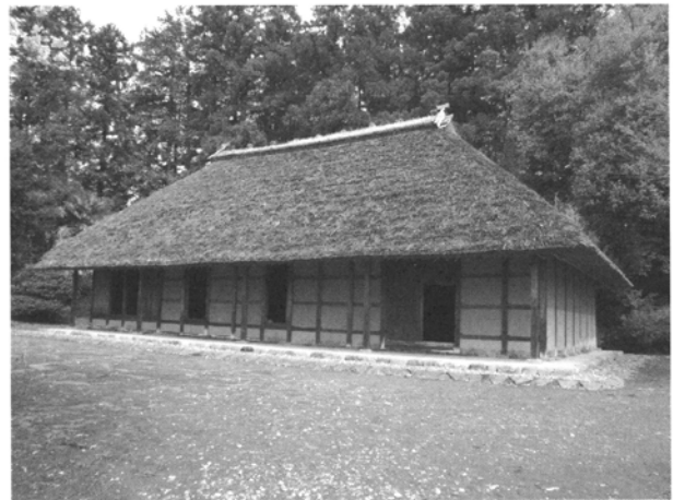
写真1. 旧阿久沢家住宅(群馬県前橋市柏倉町) [17世紀末期建造。平屋建・寄棟造・茅葺。桁行15.3m・梁行8.2mで、2号建物と同規模である。] (前橋市教育委員会の許可を得て掲載。楢崎撮影)
