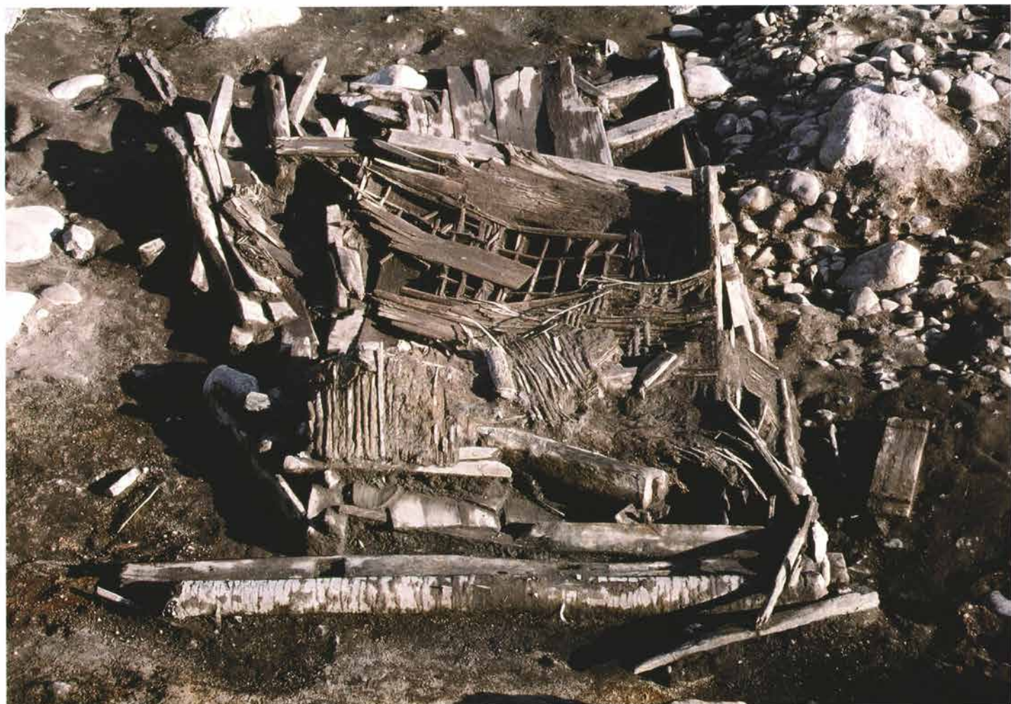
11. 上郷岡原遺跡Ⅲ区1面2号建物座敷部全景。災害現場のような生々しさが、伝わってくる。西から撮影。
