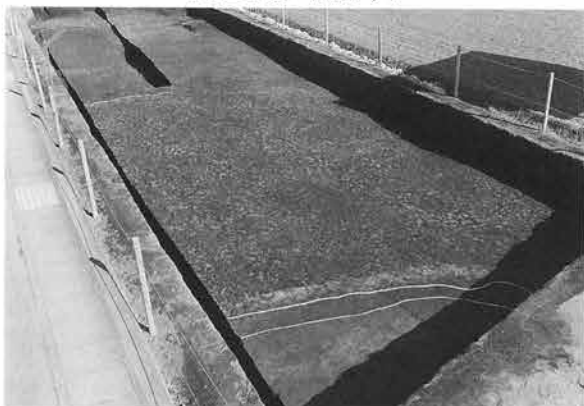
17区上面全景 (南より)
