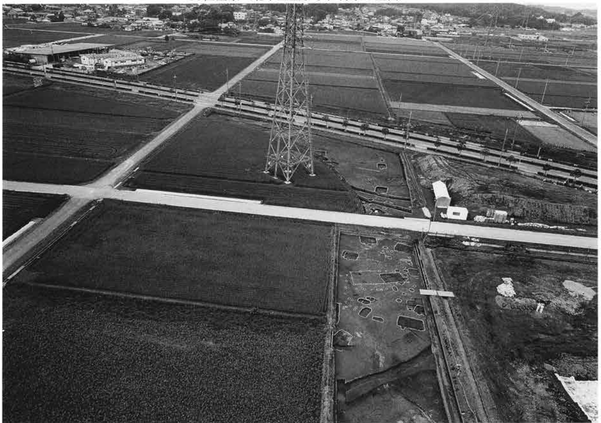
18区・21区全景（東より）
