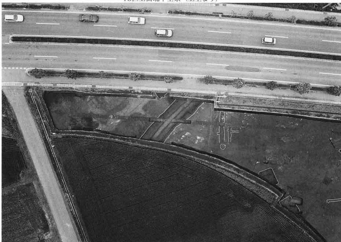
18区上面南半全景（上空より）
