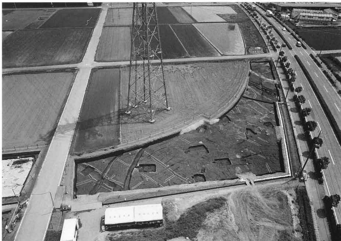
18区上面全景（上空より）
