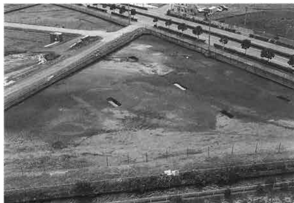
20区全景 (北東より)
