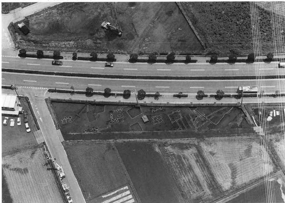
3区西半全景 (空撮)
