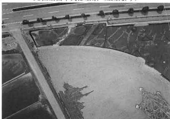
18区上面南半全景（上空より）
