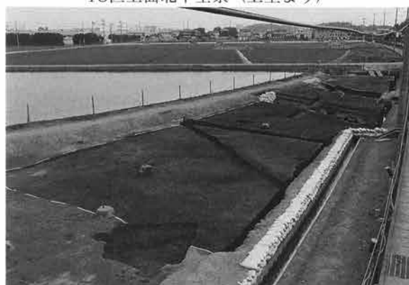
18区下面南半全景（北より）
