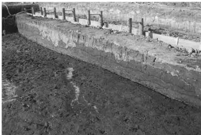
3区河道群・噴砂 土層断面 (←南東)
