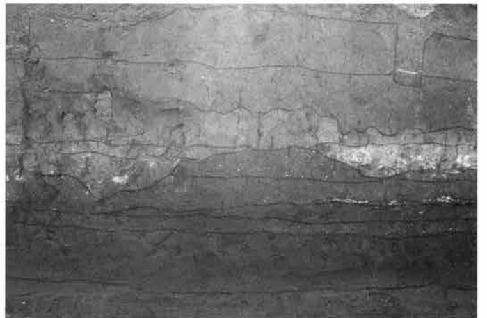
1区古代洪水層下水田 畦畔断面 (←北)
