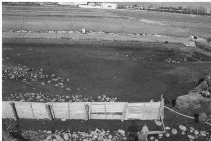
2区河道群 全景 (←南)
