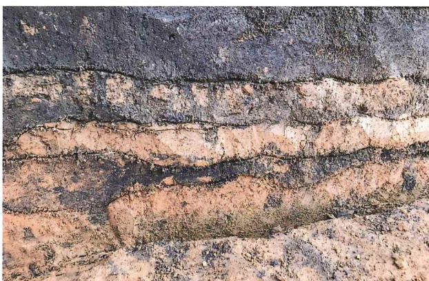
第1調査区 SH3 南壁の貼り床土層断面
