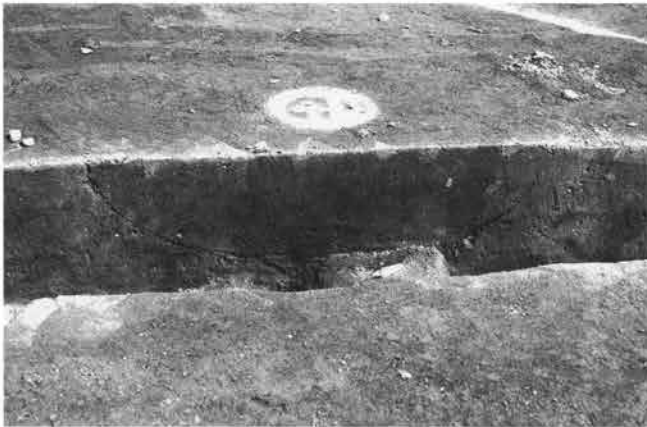
157号土坑跡 断面 (南より)
