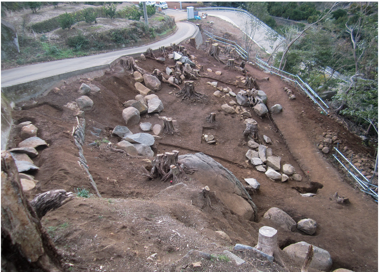
2 西浦足保林石丁場遺跡 遺跡完掘状況（東から）
