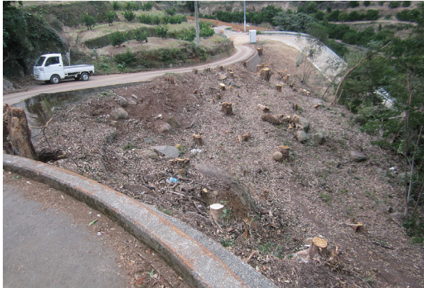
1 西浦足保林石丁場遺跡 掘削前状況（東から）
